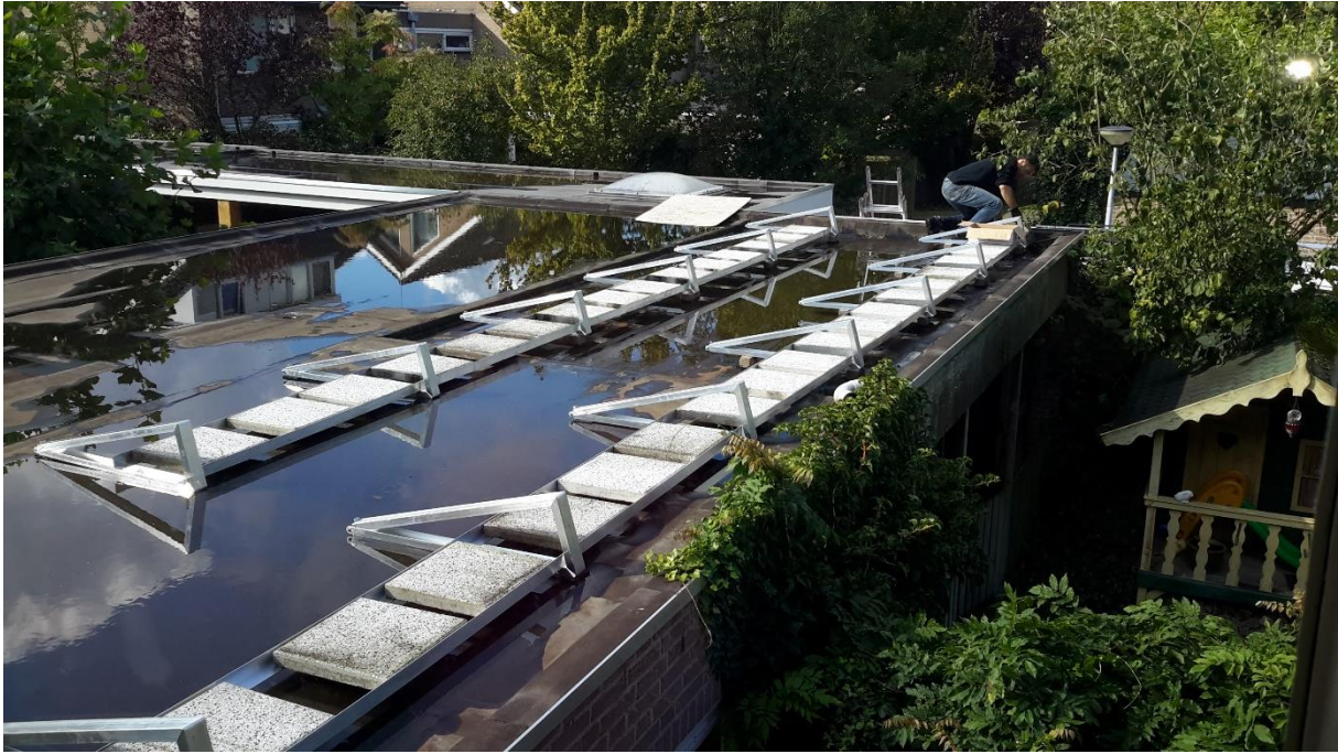
Door combinatie van water en zonnepanelen te zware dakbelasting
